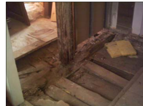
Der Fußboden in der 3. Etage bekommt Parkett.
